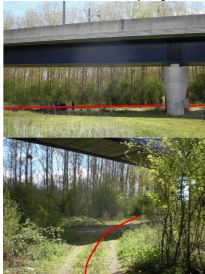
Figure 1 Viaduc de la LGV Est au niveau du passage de la canalisation
